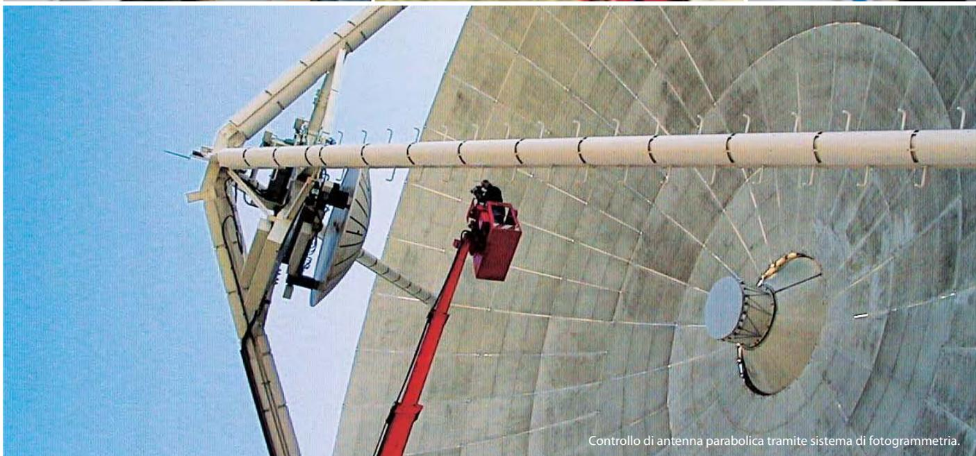
Controllo di antenna parabolica tramite sistema di fotogrammetria.
